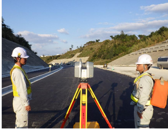
【新技術の活用「レーザースキャナー」(撮影：恩納南BP工事現場)】 喜 納 元 気
