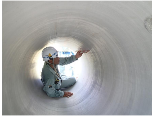
【穴の中の作業(撮影：宮古島市仲原地下ダム)】
