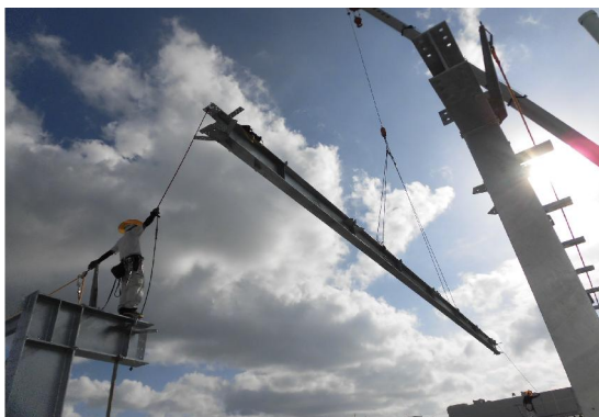
〈人〉【建て方(撮影：北谷浄水場)】 森田倫子
