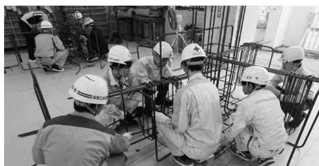
V鉄筋を組む実習を行った
