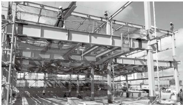
現場名：うるま配送センター新築工事の現場で、溶接部検査や柱の寸法精度計測などを行いました。
