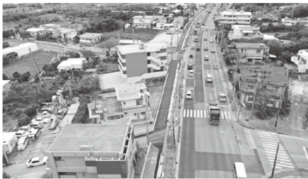
現場名：令和3年度奥間南地区改良（その2）工事
