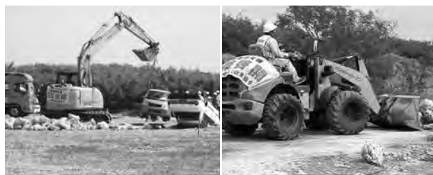
支部会員らが重機を操作して道路啓開作業などを行った
