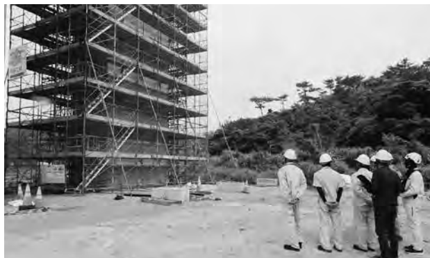
橋脚の施工工程などを見て学んだ
