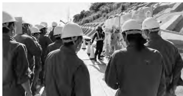
与那原地区法面工事の概要などを聞いた
