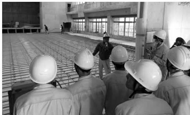
農業大学校体育館の工事を見学した
