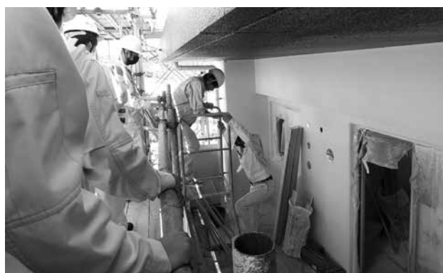
プレサンスロジェ工事現場見学の様子
