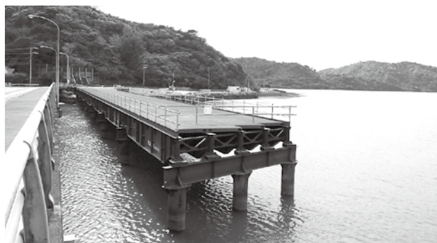
現場名：県道9号線大保大橋仮橋設置工事(R3) 主に写真管理・安全管理
