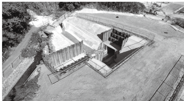
現場名：小湾川第1号雨水幹線工事(2-1) 写真管理、工事日報、安全管理
