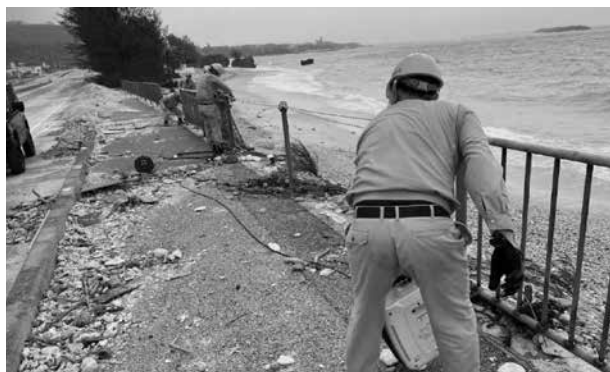
防護柵の撤去と応急復旧を行う東開発の担当者(左)と復旧後の様子(国道449号)
