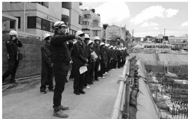
宜野湾署庁舎改築現場で工事状況などを見学した
