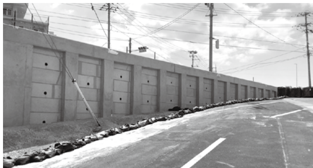
現場名：城間前田線（前田工区）街路改良工事（R3-2） 主に、写真管理（施工状況などを撮影し書面にまとめる）、安全管理（作業員とのミーティングや安全看板設置など）
