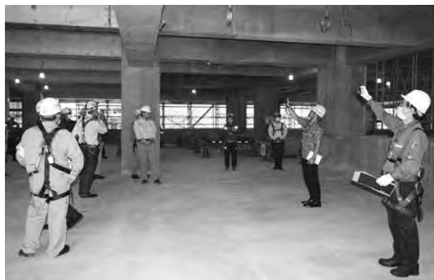
現場内の安全対策などを確認した
