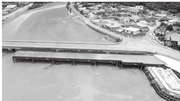
県道9号線大保大橋仮橋設置工事
