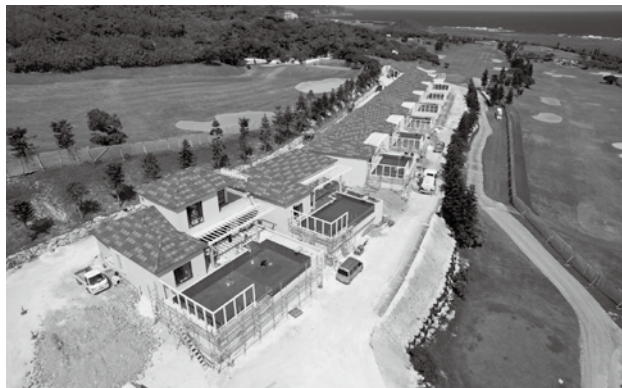
(仮称)No.11 ホールサイドホテル新築工事
