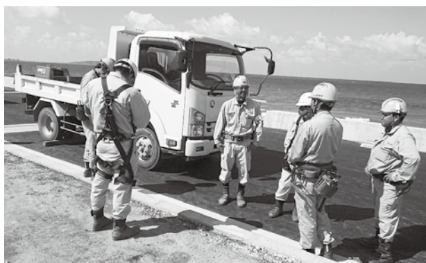
施工状況を確認する北部分会の参加者
