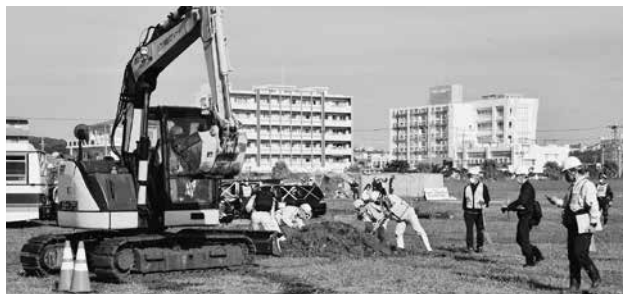
道路啓開の作業を行う沖建協の担当者ら
