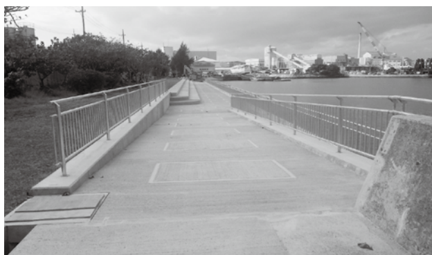
初めての現場：新港ふ頭(港町海岸)護岸工事(R2) 主に写真管理、安全管理を担当
