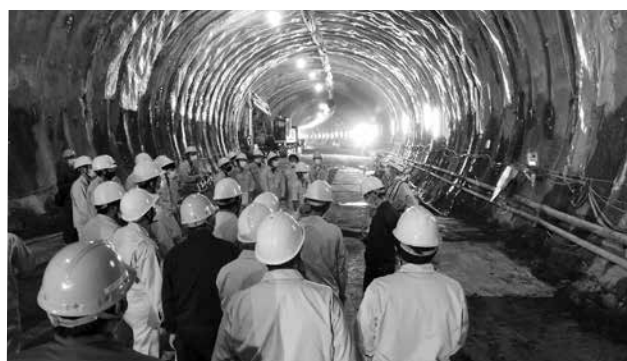
トンネル工事の状況について説明を受ける美来工科の生徒たち
