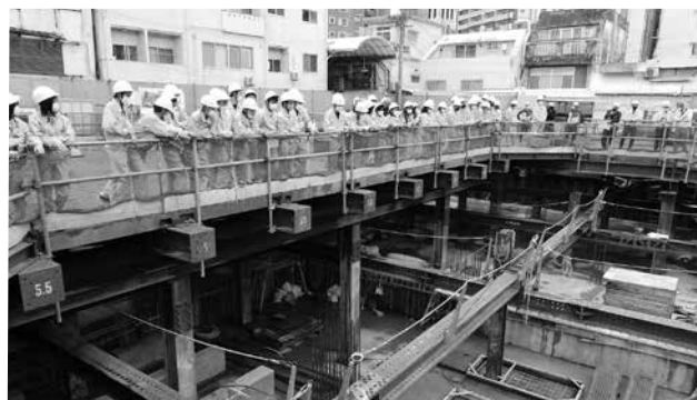
牧志公設市場の基礎工事の様子を見学する浦添工業の生徒たち
