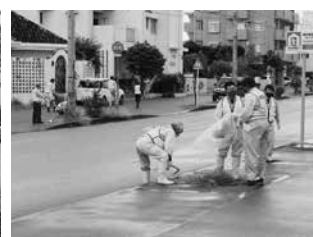
歩道を中心に作業を行った
