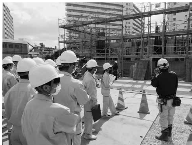
市営住宅建替工事現場を見学する美里工業高校の生徒たち
