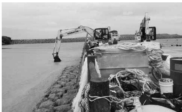
岸壁から軽石の除去を行った
