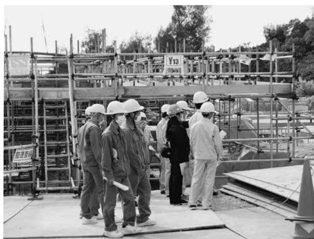
基礎工事の様子を見学する名護商工の生徒たち
