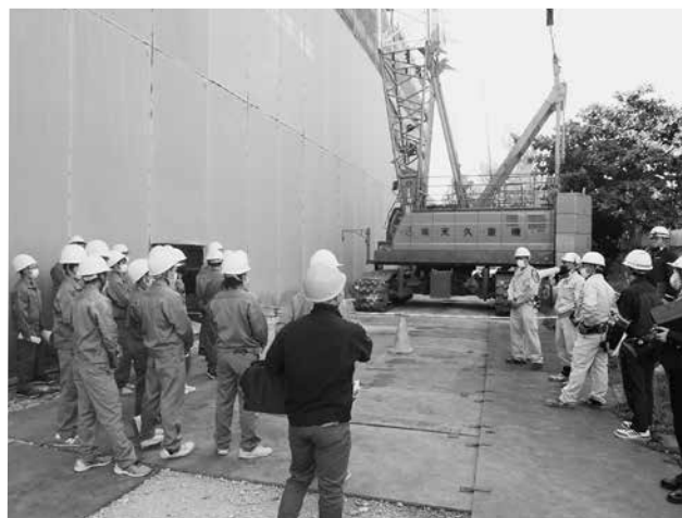
現場内のクレーンの説明を受ける南部工業高校の生徒たち
