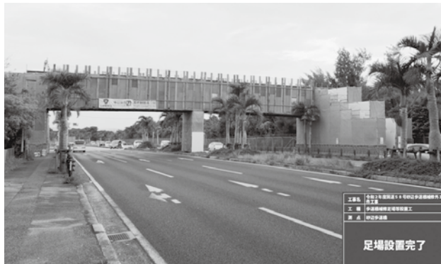
令和2年度国道58号砂辺歩道橋補修外1件工事 主に写真管理、安全管理を担当
