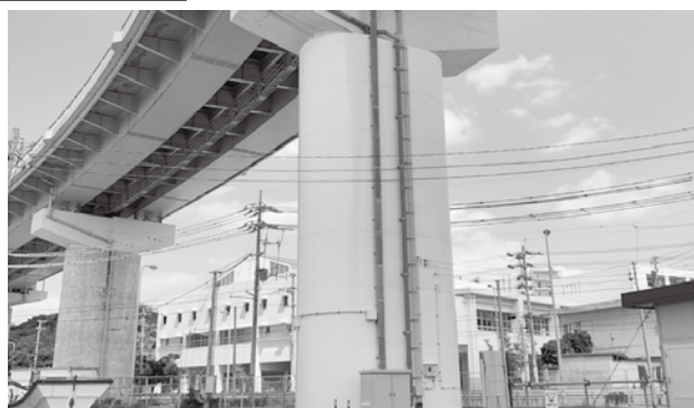
那覇港（泊ふ頭地区）臨港道路（港湾1号線）（改良）橋梁下部補強工事 那覇空港土木施設維持修繕工事
