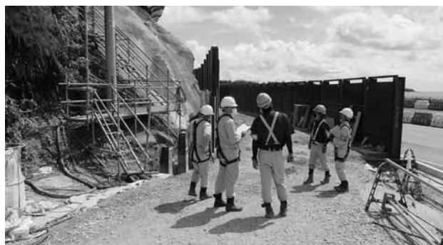
現場の安全対策を確認した(令和2年度許田地区 交通安全対策及び法面对策工事、北部分会)
