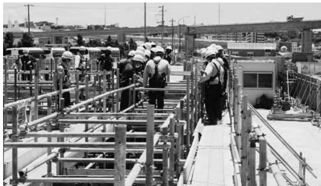
荷捌施設新築工事現場では基礎工事の工程を学んだ
