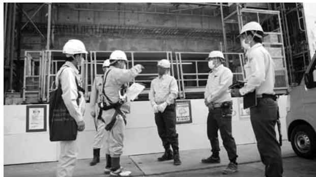
工事概要などをチェックした (仮称)九電工那覇寮新築工事、那覇分会
