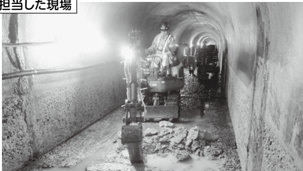
東系列導水路トンネル杉田水路橋耐震補強及び久志ダム対策工事 担当内容：写真管理
