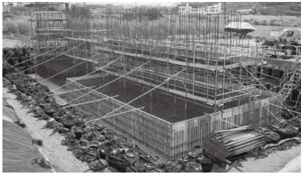
幸地インター線橋梁整備工事 (A・Dランプ下部工 A1) 主に安全管理・写真管理を担当
