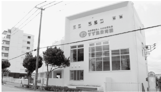
てだこ内間保育園新築工事 品質・安全・工程管理管理補助、写真管理を担当
