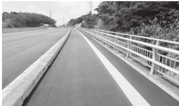
「令和元年度与那原バイパス高欄設置工事」で主に安全管理と写真管理を担当していました。
