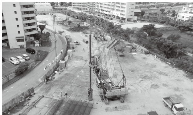
大謝名団地建替工事の現場。10階建てということでもやりがいのある現場です。
