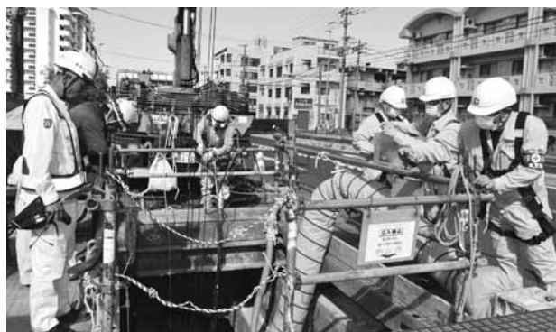
墜落防止器具の使用状況などを確認した
