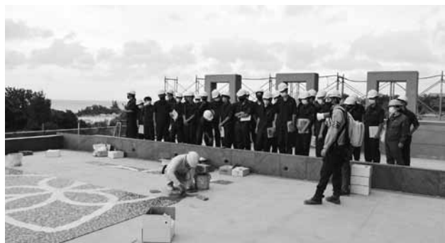
恩納村の現場ではタイル張りの作業を見学した
