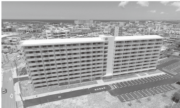
県営大謝名団地建替工事(第2期・建築1工区)
