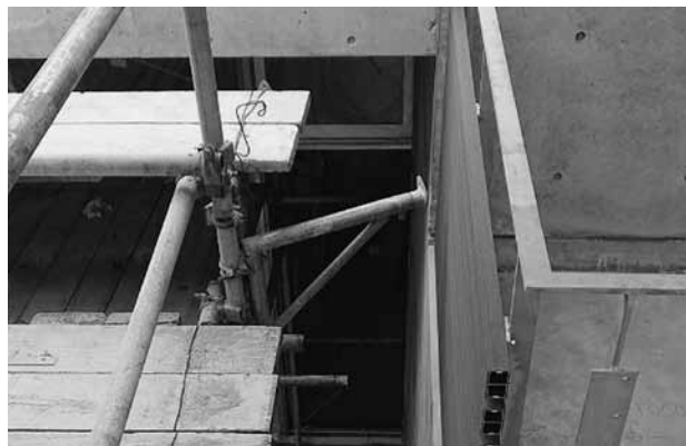
建物と足場の隙間などを確認した(北部支部)
