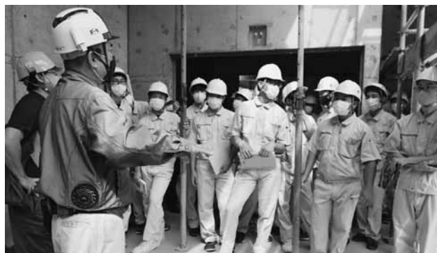
糸満市の現場では仕上げ前の内部などを見学した
