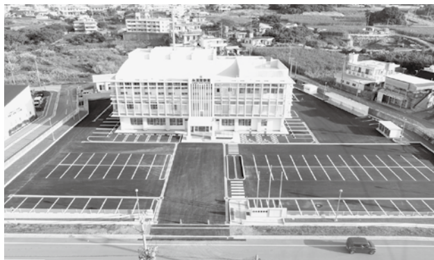
糸満警察署庁舎新築工事（建築2工区）。工程・品質・安全管理補助を担当しました。
