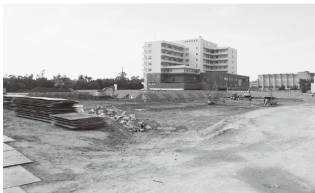
県立那覇A特別支援学校(仮称)新築工事(杭工事)。
