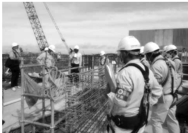
新市庁舎建設現場などパトロール
