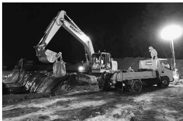
埋却作業の様子
