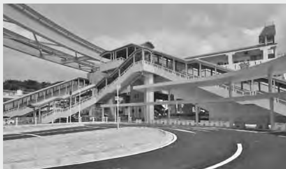
「城間前田線都市モノレール浦添前田駅 自由通路建設工事(南)」
