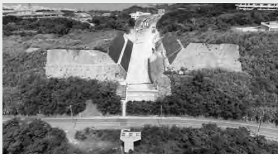
「H30南部東道路橋梁下部工事 (大城ダム3号橋A2)」
