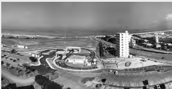
「浦添西原線 (港川道路)第4ゲート整備工事(H30-4)」
