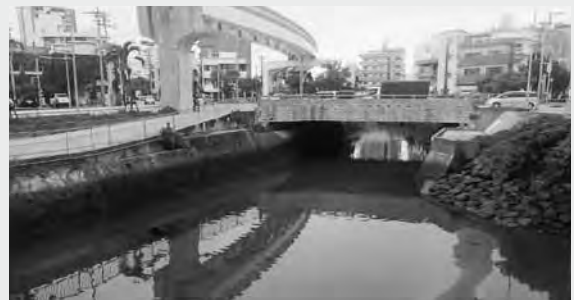
「安里川河川浚渫工事(H30-1)」
