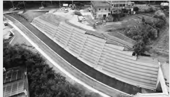
「城間前田線街路改良工事(H30-2)」
