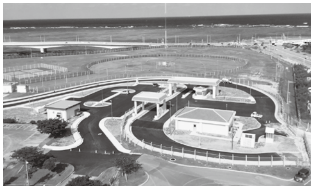
キャンプ・キンザーゲート4関連施設新築工事（機械）。工程、品質、安全管理補助を担当。
