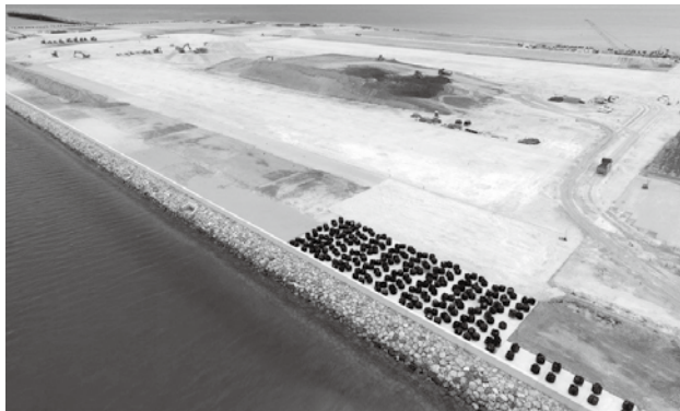
那覇空港滑走路増設1工区埋立工事。初めてのJVの現場で、材料検収や写真管理、安全管理を担当。
