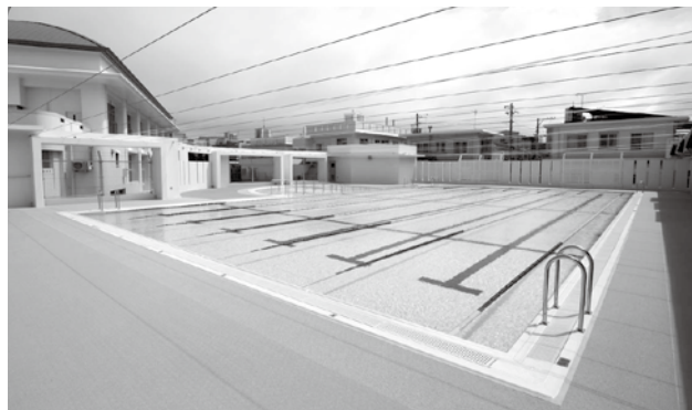
完成した「浜川小学校プール改築」。主に写真管理や安全管理、労務管理を担当した。
