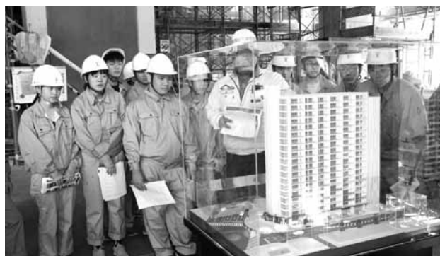
農連市場防災街区南地区第二期工事現場(10月31日、浦添工業高校1年生)
