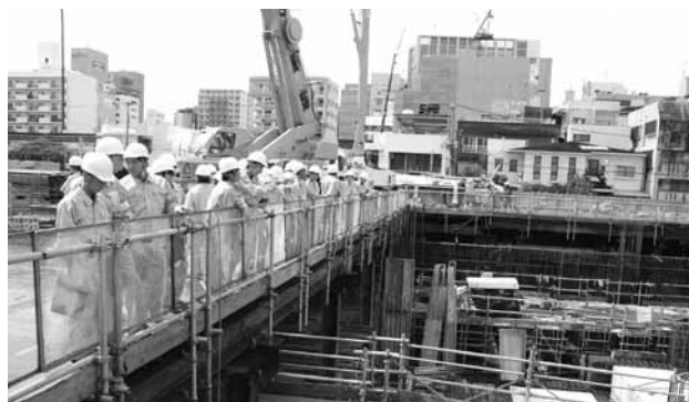
那覇市新市民会館建設現場(9月19日、美里工業高校)
