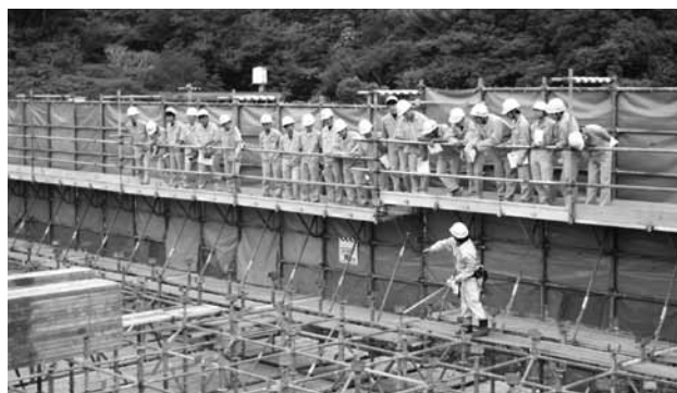
名護東道路数久田高架橋工事現場(11月19日、沖縄工業高校)
