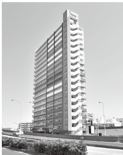
プレサンスロジエ牧港レーヴタワー 新築工事の現場。工程・品質・安全管理補助などを担当。
