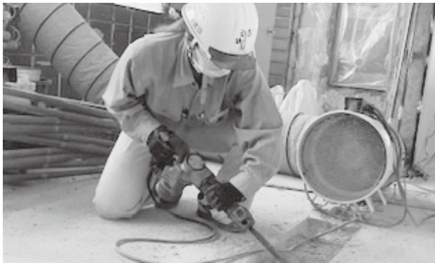
自動ドアをつけるため削岩機で削り作業をしているところ。
