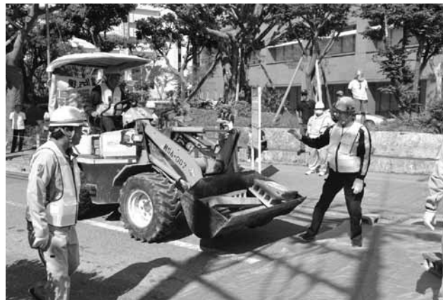
協力して撤去作業を行った
