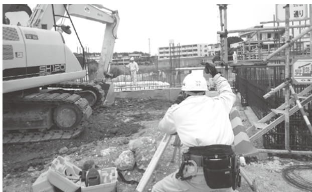
土間下捨てコンクリート天端の確認作業。
