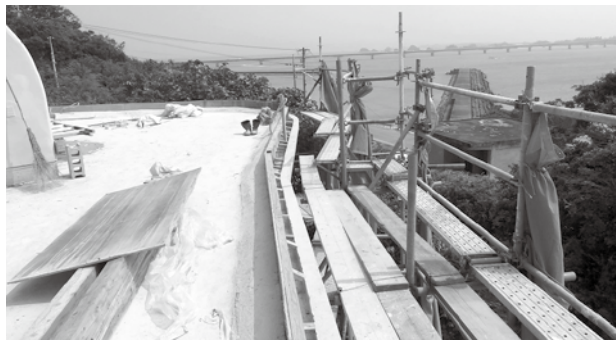
躯体と足場の間隔をチェック
