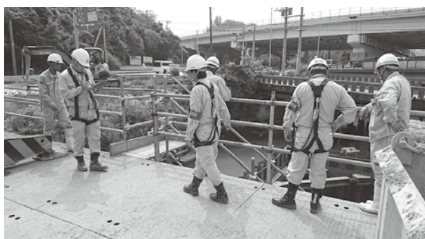
ステージの落下防止対策を確認
