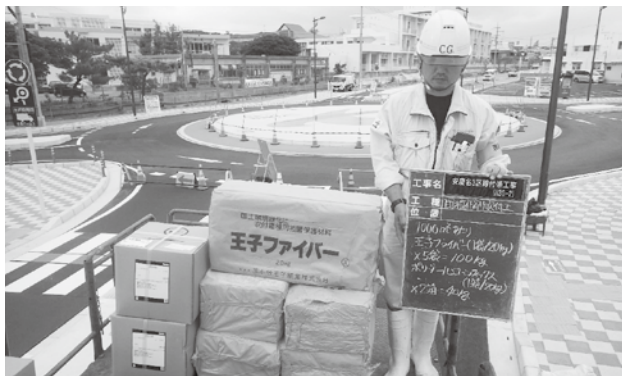
安慶名3区線交差点改良工事（ラウンドアバウト）で監督補助の仕事に携わりました。
