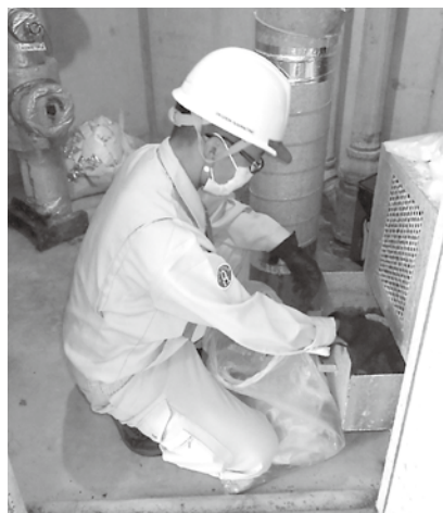
「キャンプフォスターダクト清掃」。現場管理を担当、日々先輩や職人の方々からアドバイスを頂き仕事をしています。
