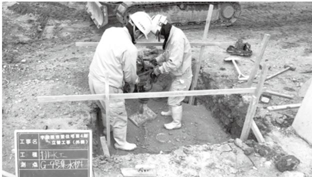
宇栄原市営住宅第4期建替工事 (外構)。基礎材 (RC-40) 敷均し転圧しているところ。
