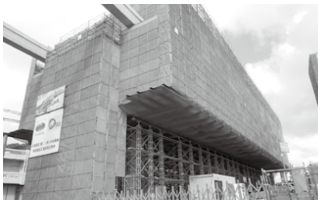
城間前田線都市モノレール浦添前田駅建設工事(建築)
