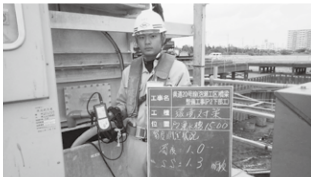
県道20号線(泡瀬工区)橋梁整備工事(P2下部工)。主に環境対策で濁度測定と写真管理をしていました。
