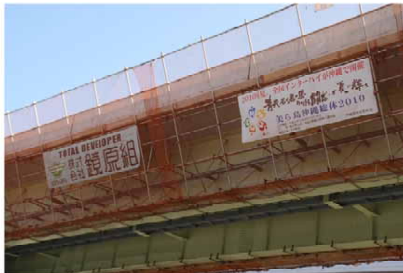
那覇空港自動車道豊見城口高架橋 (株)鏡原組
