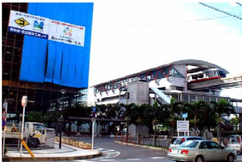
モノレール壺川駅隣り② (株)國場組
